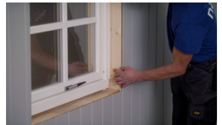
Benytt kiler til å gi luft mellom lysåpning og vindu
